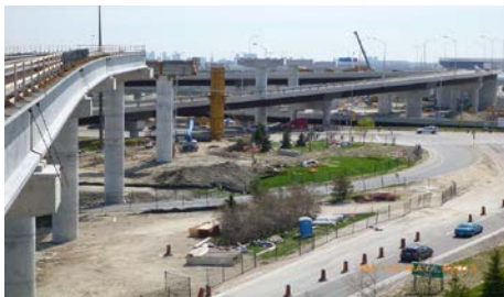
Vue à l'ouest du pilier de l'embranchement 57
